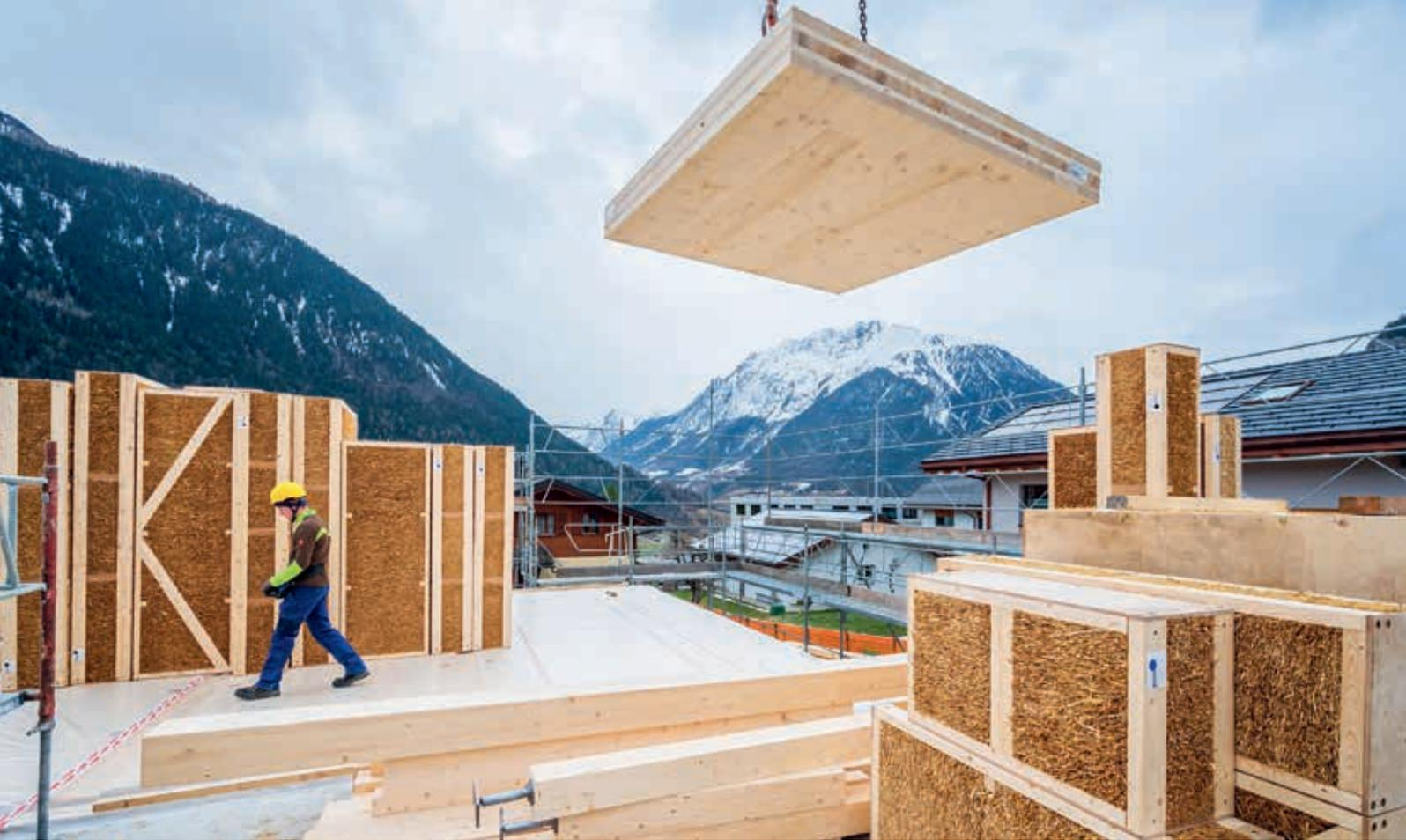
Neubau eines Mehrfamilienhauses nach GEA-K-A/A-Standard in Vollèges (VS), dessen Wände aus wärmeisolierendem Stroh sind.
